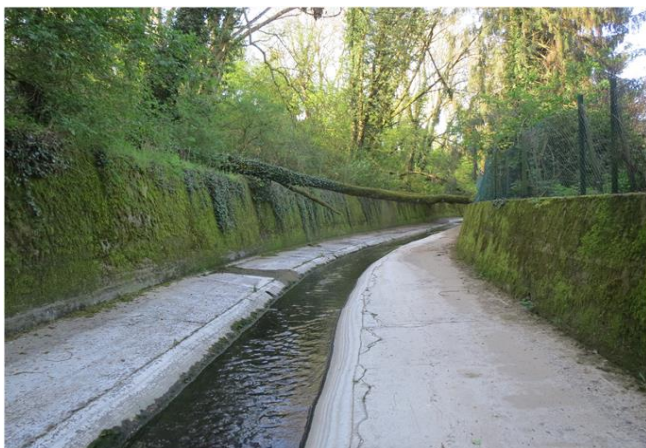
Foto gegen Fließrichtung
