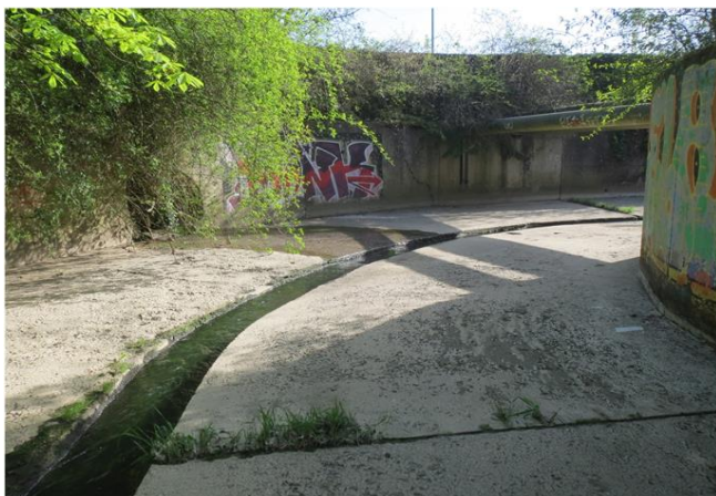
Foto gegen Fließrichtung
