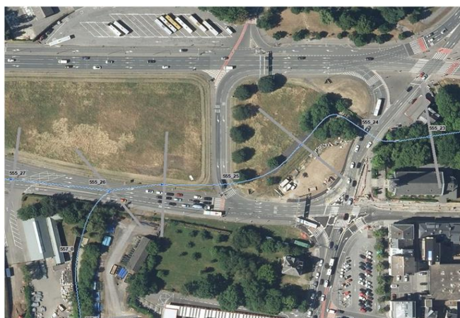
Foto gegen Fließrichtung
