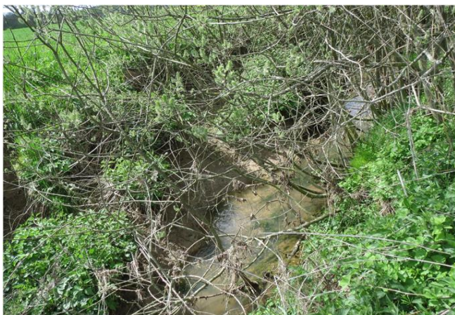
Foto gegen Fließrichtung
