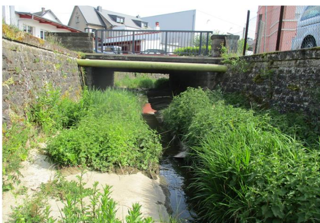
Foto gegen Fließrichtung
