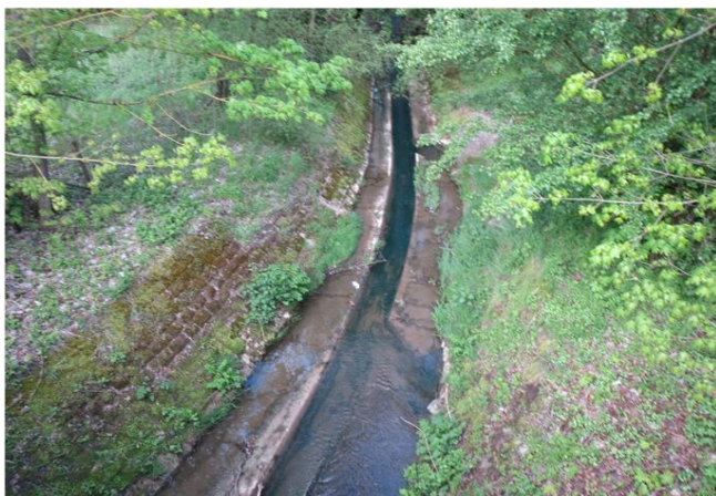
Foto gegen Fließrichtung
