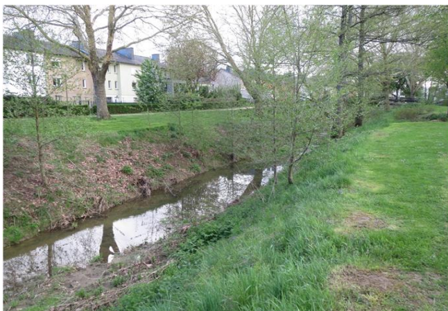
Foto gegen Fließrichtung
