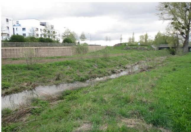
Foto gegen Fließrichtung
