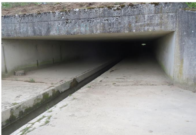
Foto gegen Fließrichtung
