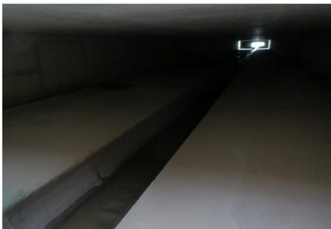
Foto gegen Fließrichtung
