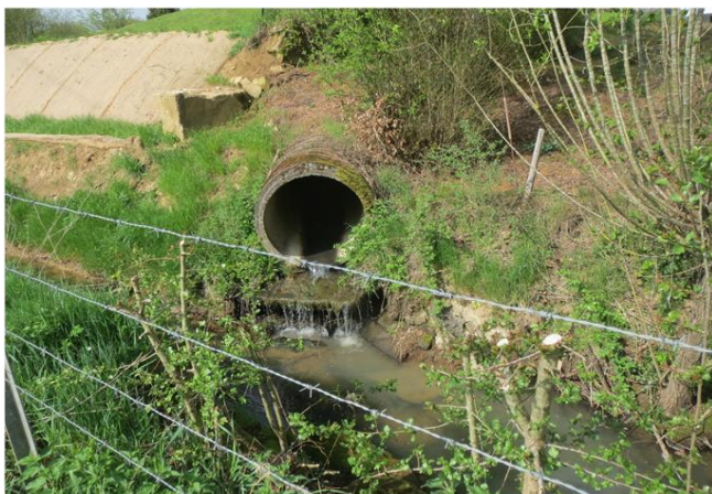
Foto gegen Fließrichtung
