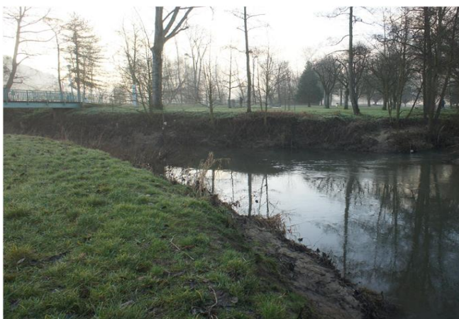
Foto gegen Fließrichtung
