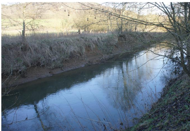
Foto gegen Fließrichtung
