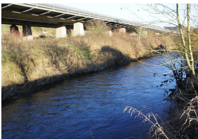
Foto gegen Fließrichtung
