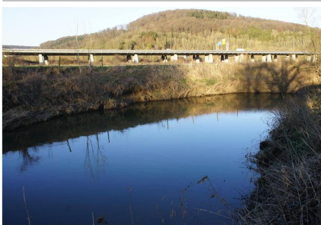
Foto gegen Fließrichtung
