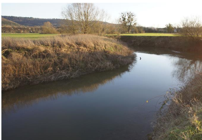
Foto gegen Fließrichtung
