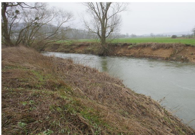
Foto gegen Fließrichtung
