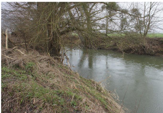
Foto gegen Fließrichtung
