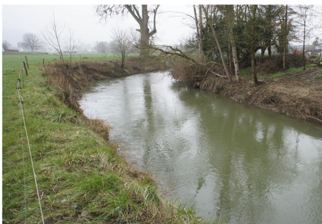
Foto gegen Fließrichtung
