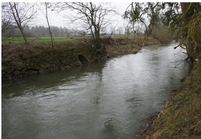
Foto gegen Fließrichtung
