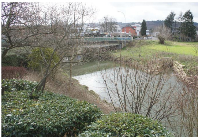
Foto gegen Fließrichtung
