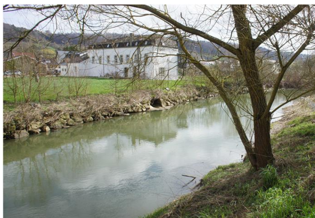
Foto gegen Fließrichtung
