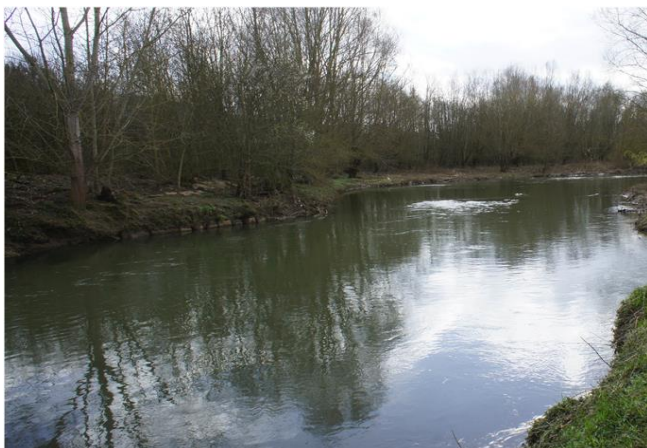
Foto gegen Fließrichtung
