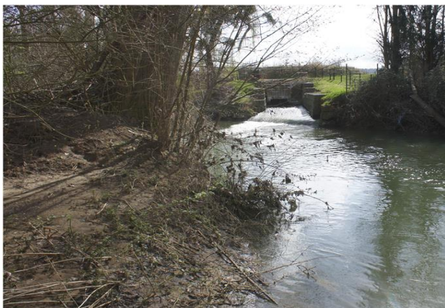
Foto gegen Fließrichtung
