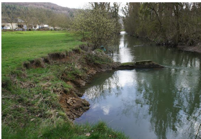
Foto gegen Fließrichtung
