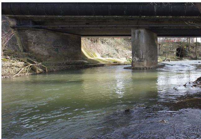
Foto gegen Fließrichtung
