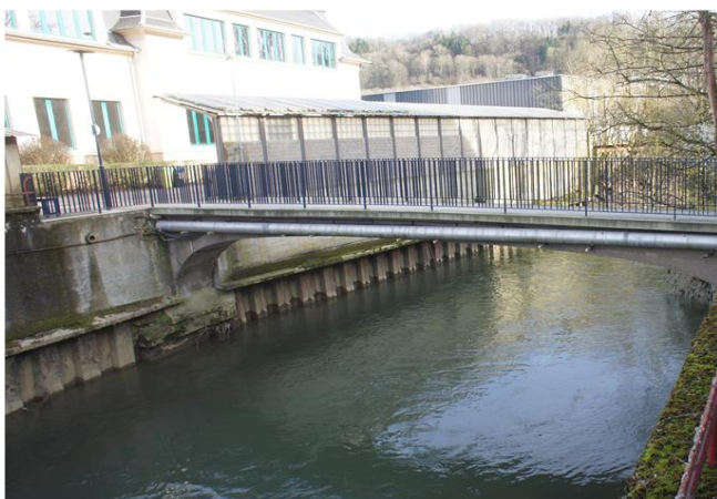
Foto gegen Fließrichtung
