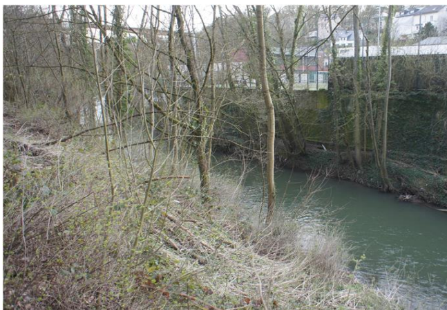
Foto gegen Fließrichtung
