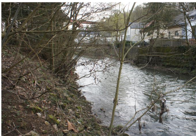
Foto gegen Fließrichtung
