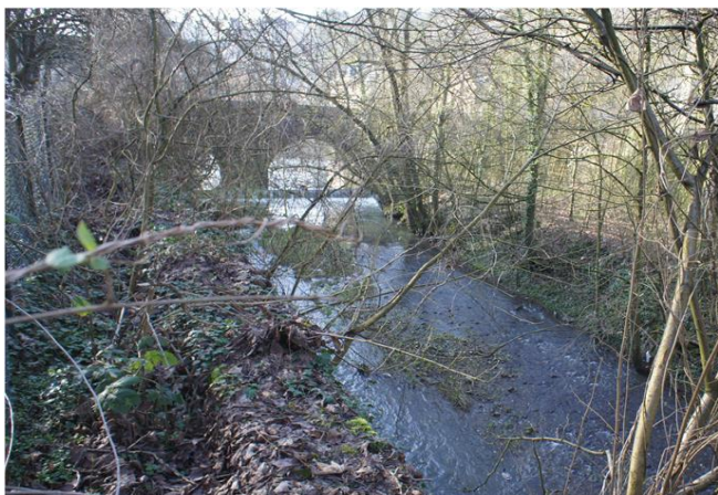
Foto gegen Fließrichtung
