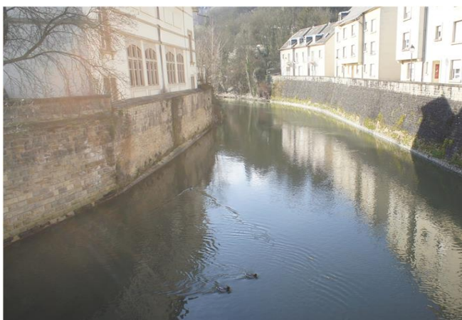
Foto gegen Fließrichtung
