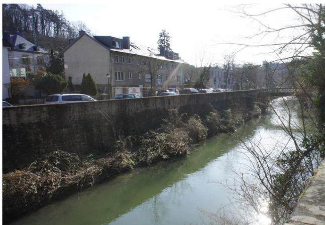
Foto gegen Fließrichtung
