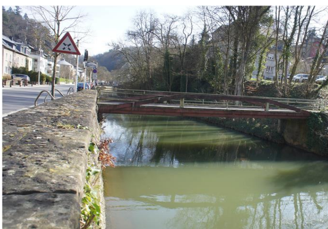
Foto gegen Fließrichtung
