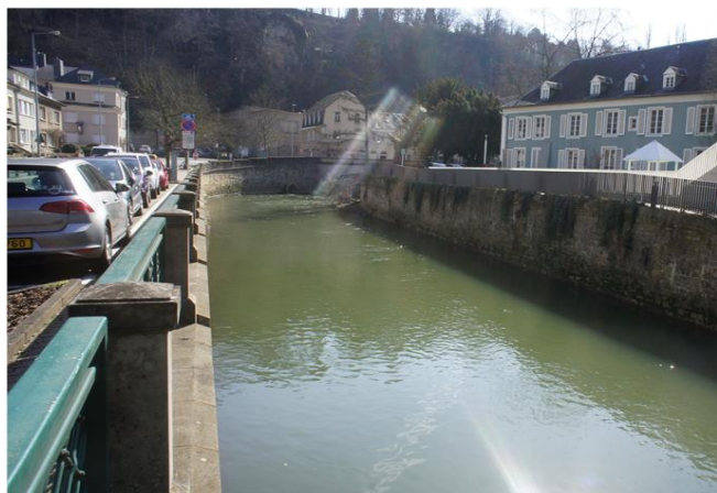
Foto gegen Fließrichtung
