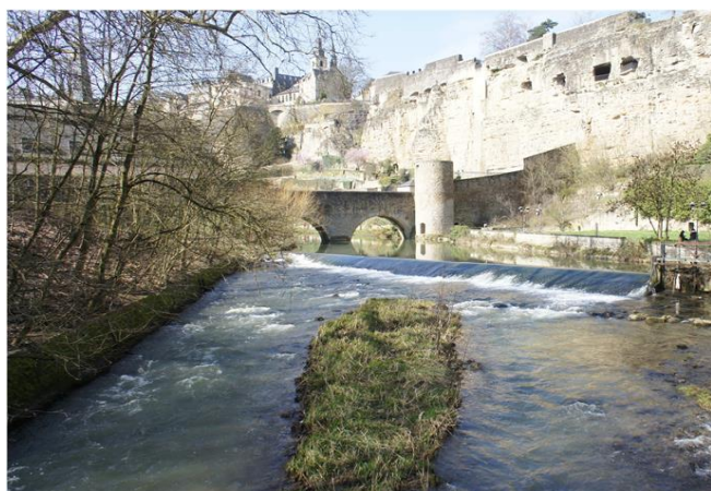
Foto gegen Fließrichtung
