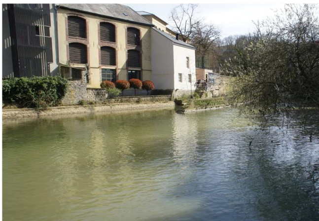
Foto gegen Fließrichtung
