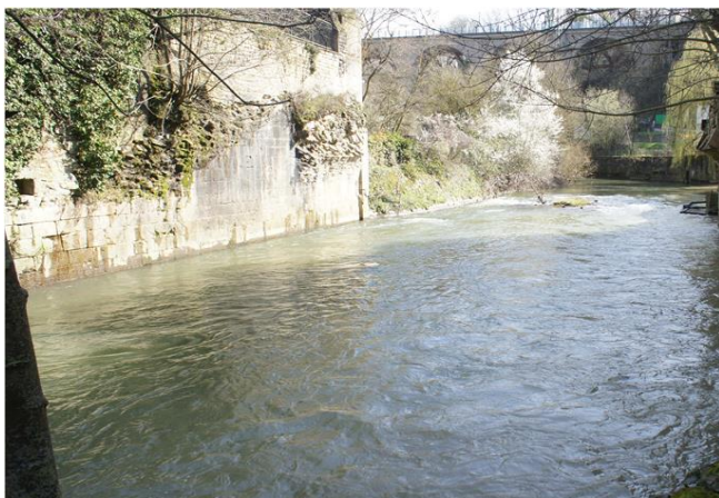
Foto gegen Fließrichtung
