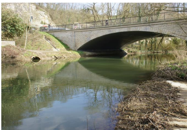
Foto gegen Fließrichtung
