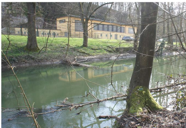
Foto gegen Fließrichtung
