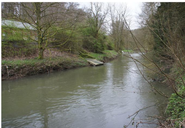
Foto gegen Fließrichtung
