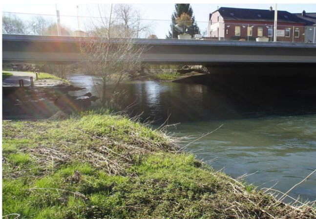
Foto gegen Fließrichtung
