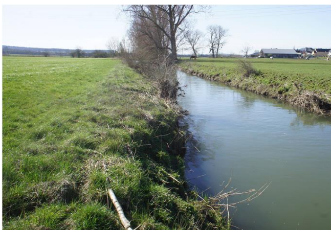
Foto gegen Fließrichtung
