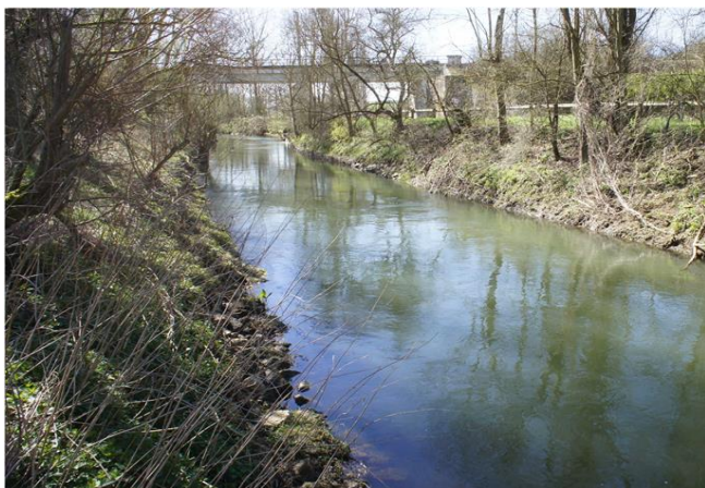
Foto gegen Fließrichtung
