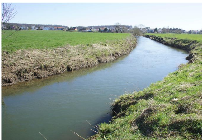
Foto gegen Fließrichtung
