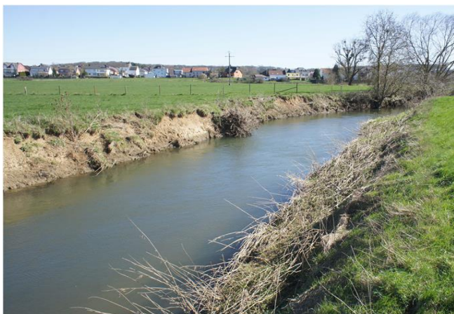
Foto gegen Fließrichtung
