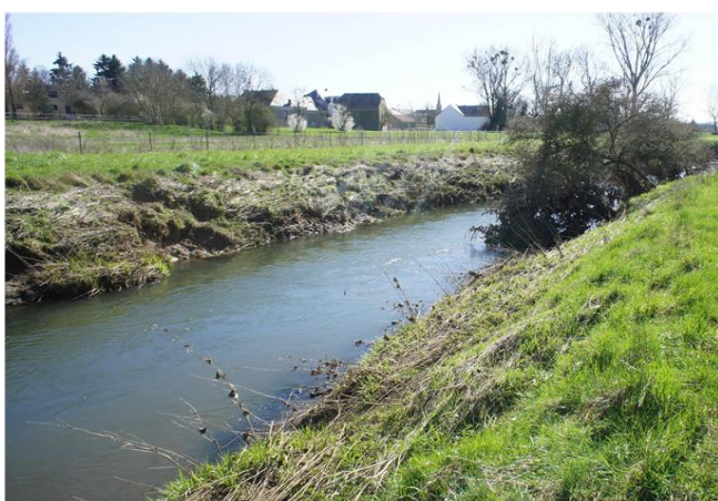
Foto gegen Fließrichtung
