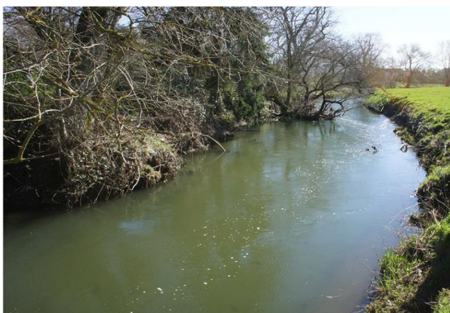
Foto gegen Fließrichtung
