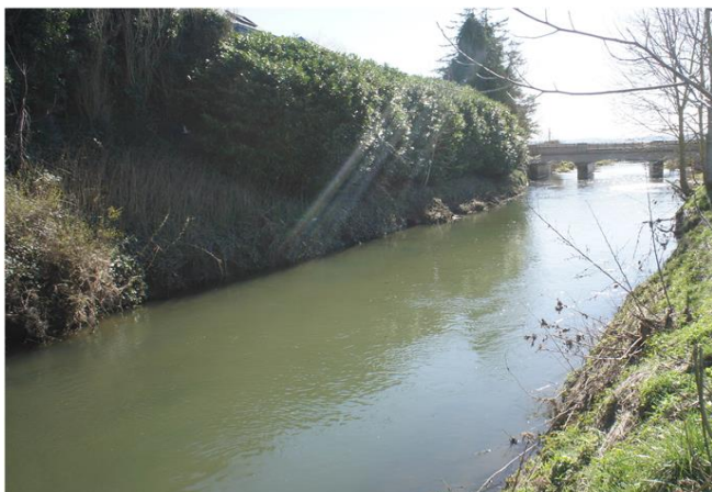
Foto gegen Fließrichtung
