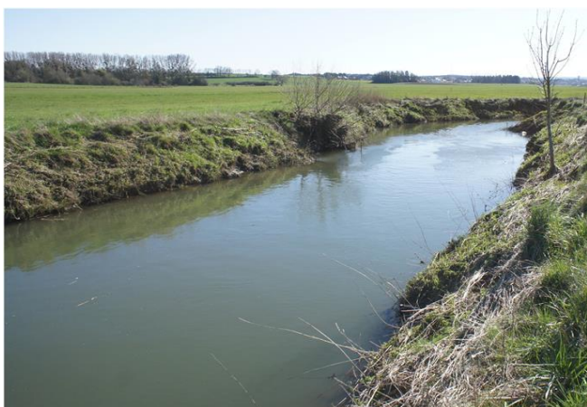
Foto gegen Fließrichtung
