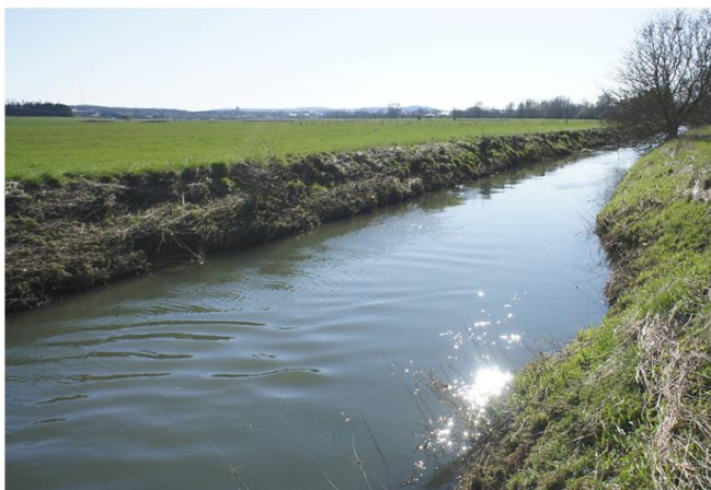
Foto gegen Fließrichtung
